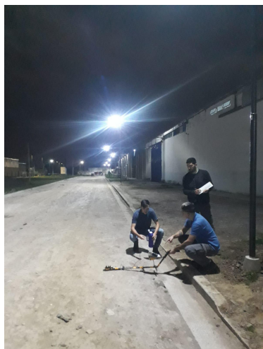
Fig. 3. Ensayo de campo para la medición de iluminancia posterior a instalación.
