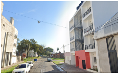
Fig. 2. Fotografía de luminaria deteriorada.
