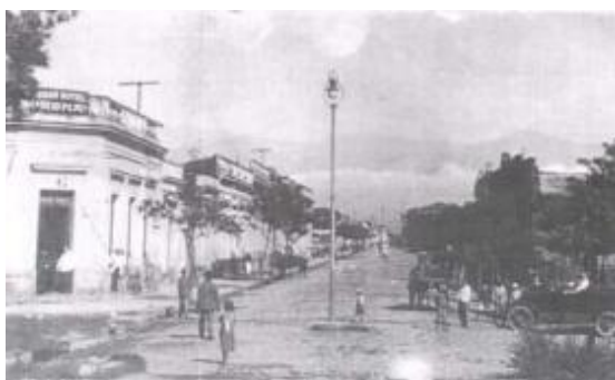
Fig. 2 Imágenes de las calles 25 de Mayo y Santiago en el año 1925, donde podemos observar luminaria central con lámparas incandescentes
