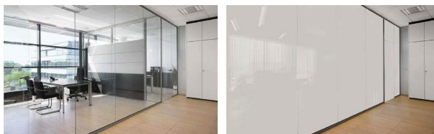
Fig. 6: Los vidrios inteligentes. permiten controlar fácilmente la transmitancia. Imagen: gentileza de Smart Glass Country ( https://www.smartglasscountry.com/ )
