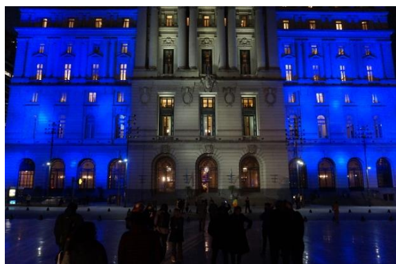
Fig. 7 - Fachada del CCK
