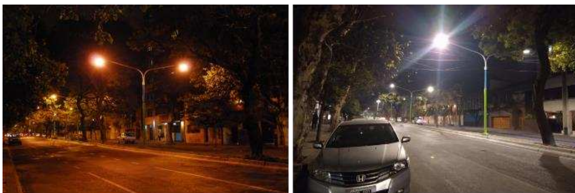
Fig. 5: Comparación de Av. Sarmiento 200 (S.M de Tucumán) con luminarias de HPS a la izquierda y luminarias LED a la derecha
