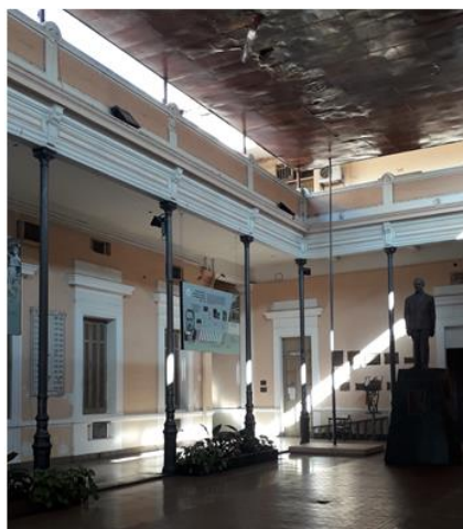
Fig. 15: Patio principal del edificio del rectorado de la Universidad Nacional de Tucumán
