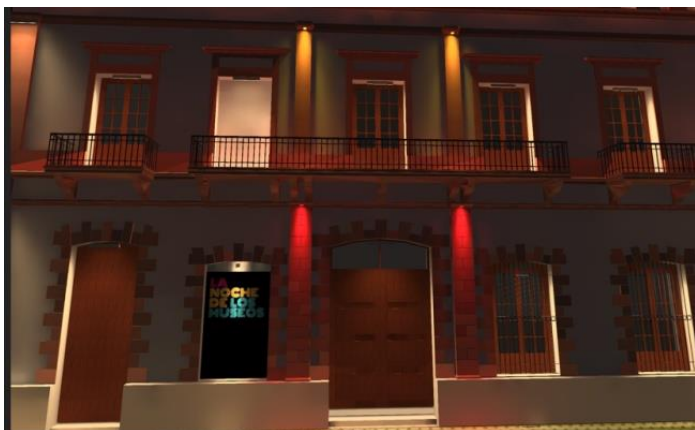
Fig 4. Iluminación cromática de puerta principal y de planta alta
