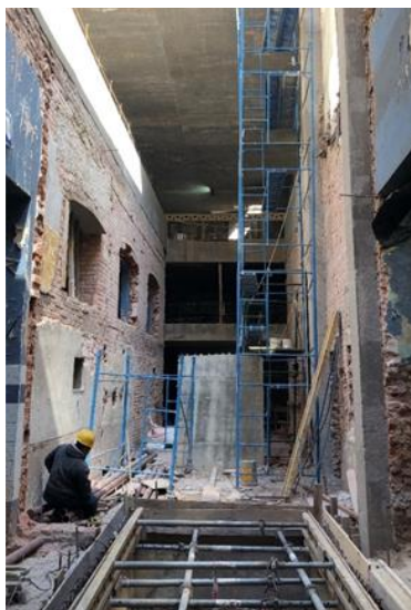
Fig. 1: El edificio antes de la restauración.
