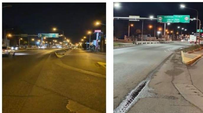
Fig. 11. Ex Ruta 22 acceso a Neuquén. Foto Izq. Iluminación Sodio. Foto Der. Iluminación LED
